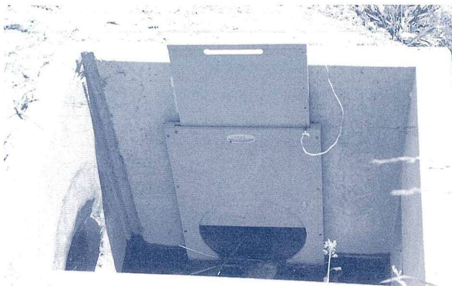
宮城県（県営） 宮城県志波姫地区 荒町南工区小用水路工事
